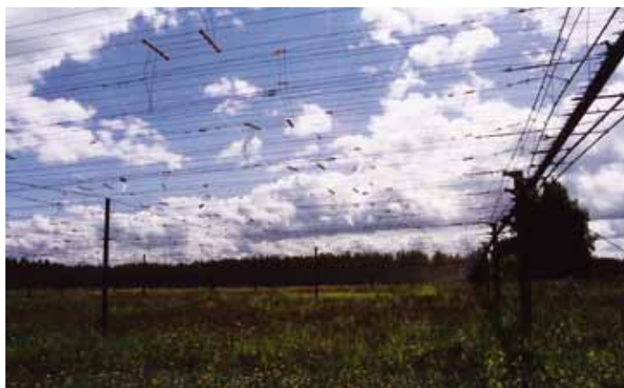
Fig. 2 - Uma rede de dipolos do observatório de Puschino (Rússia), com 70000 m 2 de área coletora.
