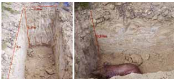
Fig. 4 - Fotografias captadas no dia do enterramento dos porcos. Esquerda: cova aberta; direita: enterramento de porco (~0,80 m).
