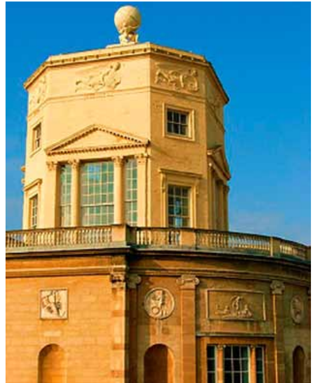
Fig. 2 - A torre do observatório Radcliffe, que funcionou de 1773 até 1934. Aqui trabalhou Norman Pogson, em princípio de carreira, de 1852 a 1859.
