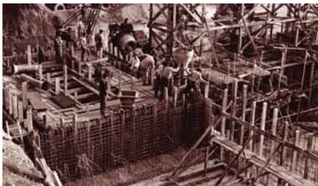
Fig. 1. Aspecto da construção do edifício do RPI (18/12/1959)
