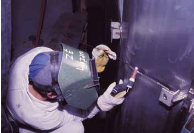
Fig. 5. Soldadura de chapas de aço do revestimento da secção I da piscina, instalado no fim da década de 1980.
