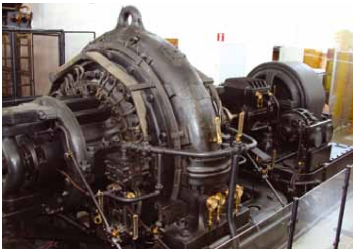
Fig. 2 - Transmissor de Alexanderson da estação de Grimeton.
