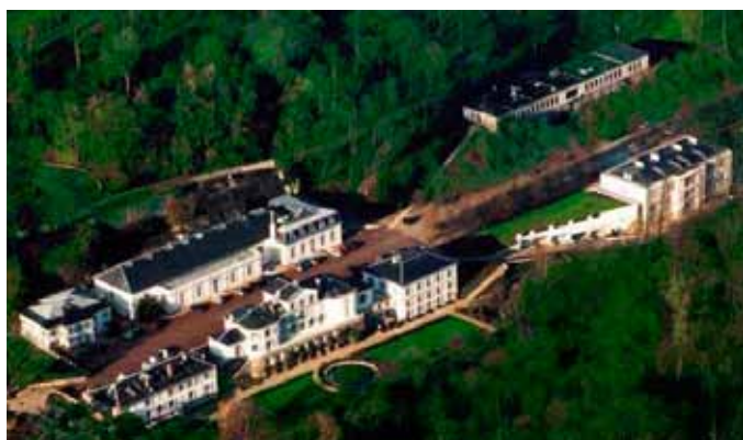
Fig. 1 - Pavilhão de Breteuil, Sèvres, França: sede do Bureau Internacional dos Pesos e Medidas (BIPM)
