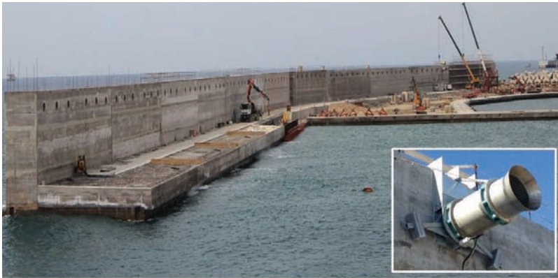
Figura 9 - Quebra-mar do porto de Civitavecchia, Itália, integrando 124 OWC.
