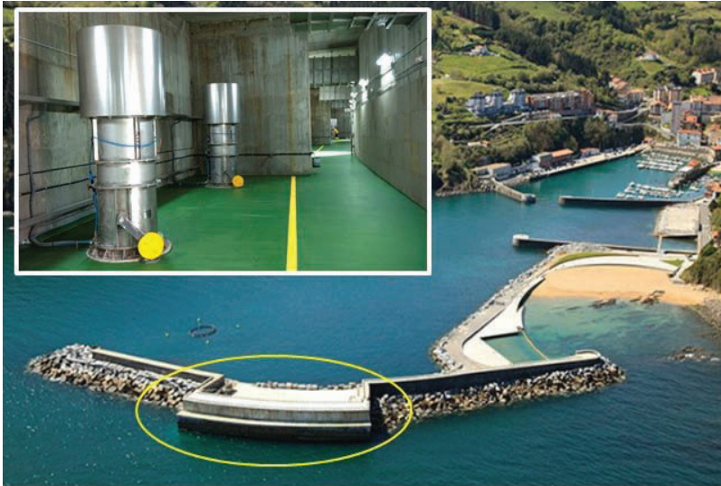
Figura 8 - Central de ondas com 16 OWC integradas num quebra-mar do porto de Mutriku, País Basco.
