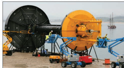
Figura 4 - Conversor de dois corpos oscilantes PowerBuoy (EUA) instalado em Santoño, norte de Espanha.
