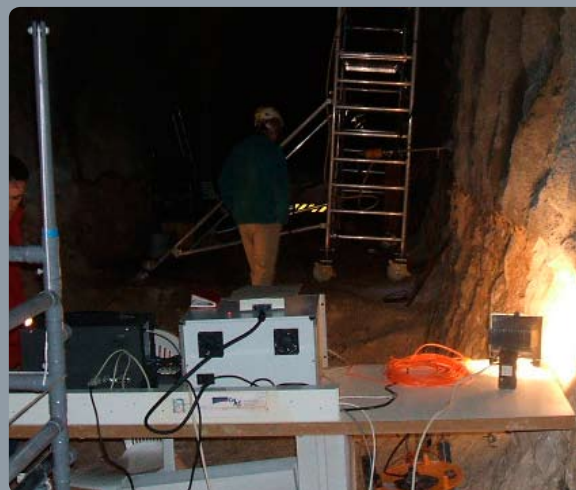
HPPCO2 (fixação e armazenamento de CO2)
