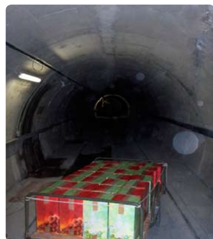
Os corredores do túnel
