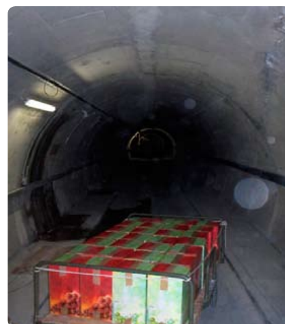
Os corredores do túnel
