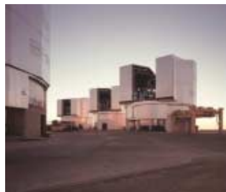
Observatório do ESO no Cerro Paranal (Chile)
